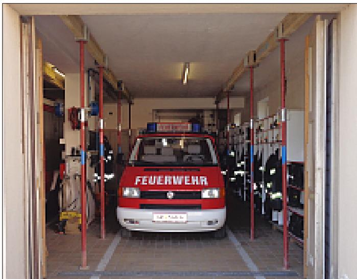
Die Decke ist umgehend durch eine Unterstellung zu sichern! Um eine Gefährdung der KameradInnen auszuschließen forderte das Feuerwehrkommando eine umgehende Umsetzung der festgesetzten Maßnahmen (Unterstellung). Der Zutritt zu den Räumlichkeiten wurde vom Feuerwehrkommandanten bis auf weiteres untersagt!
